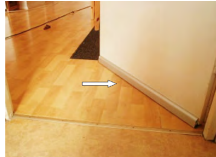
Poistettu kynnyks ja asennettu oveen tiivistekynnyks, jonka avulla saavutetaan hyvä äänieristys ja vedottomuus.
