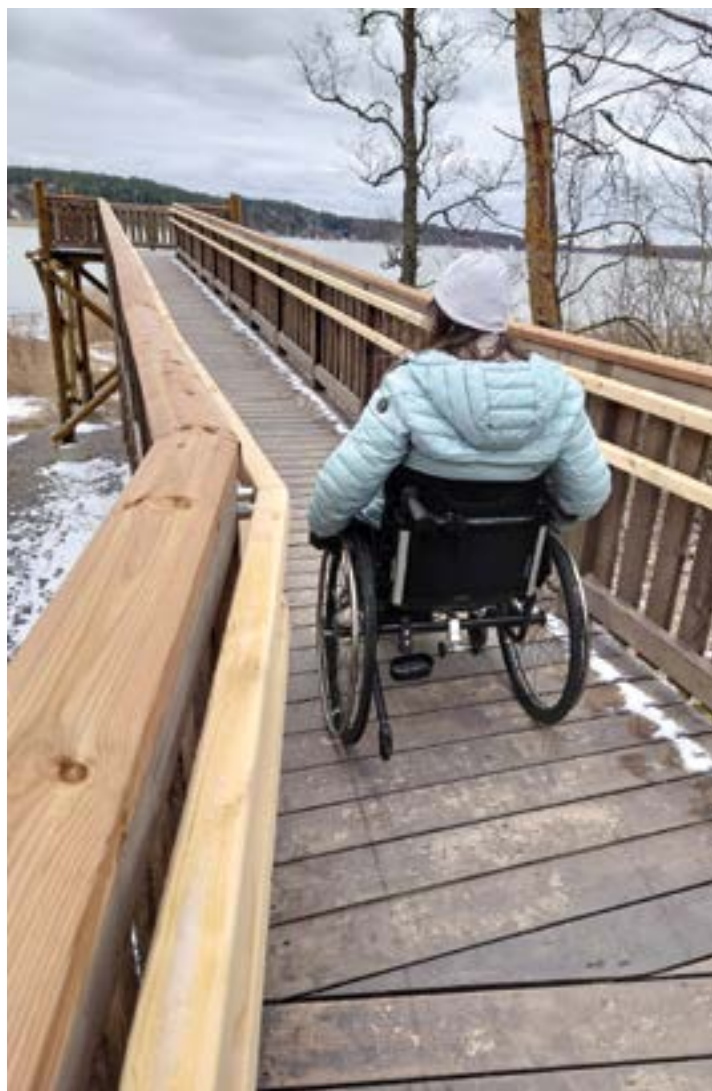
Tornille vievä luiska on riittävän loiva myös pyörätuolin käyttäjän näkökulmasta. Tukevat kaiteet helpottavat ja ovat ennenkaikkea turvallisuustekijä. Näin kulku korkealle tuntuu vähemmän pelottavalta.
